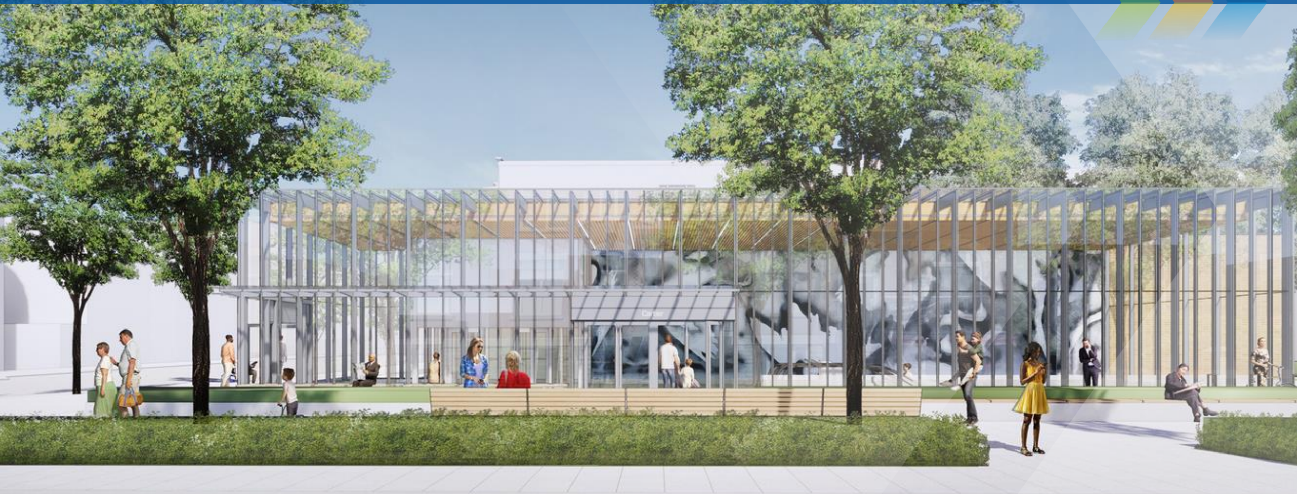
Station Cartier (extérieur)
